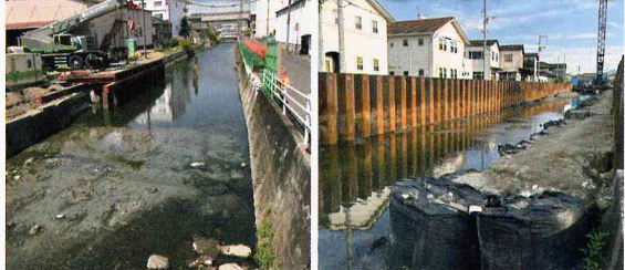
手城川と谷地川の浚渫・護岸強化、手城ポンプ場の強化が一体進む。
